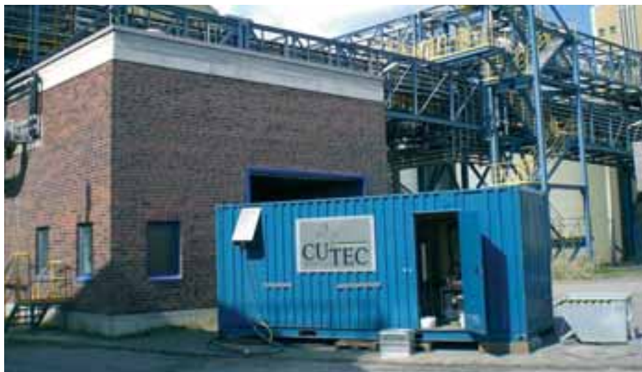
Containerversuchsanlage auf der METHA III
